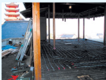
お湯を流すパイプを配管しました。これをコンクリートで埋め、お部屋になります。奥には五重塔が見えます。
