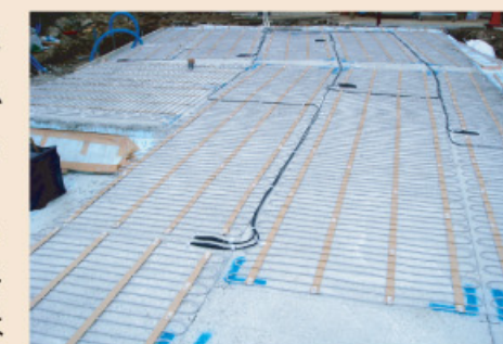
ヒータの敷設写真
