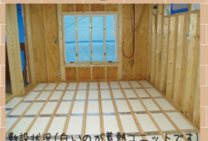
敷設状況(白いのが蓄熱ユニットです)
